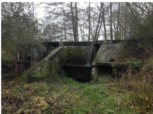
Stufenkraftwerk Camberg (Ansicht von Süden) Foto: Hartmann-Menz
