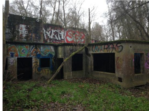
Stufenkraftwerk (Ansicht von Nordosten) Foto: Hartmann-Menz
