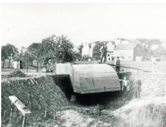
Stufenkraftwerk Camberg Bauphase Quelle: STAC
